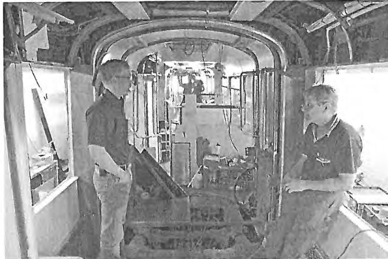
Kuva 3 Korjaamopäällikkö Petri Norrena ja asentaja Tapani Kolu työpalaverissa.
